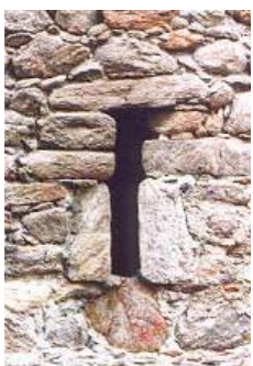
Detail eines Fensters oder vielmehr "Lichtschlitzes" des Eyrser Turmes.
