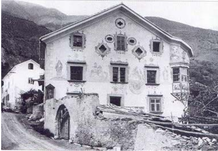
Kortsch: Matatschhof, auch Schlipfhof genannt, ein Gebäude mit reicher Fassadenmalerei von 1683.
